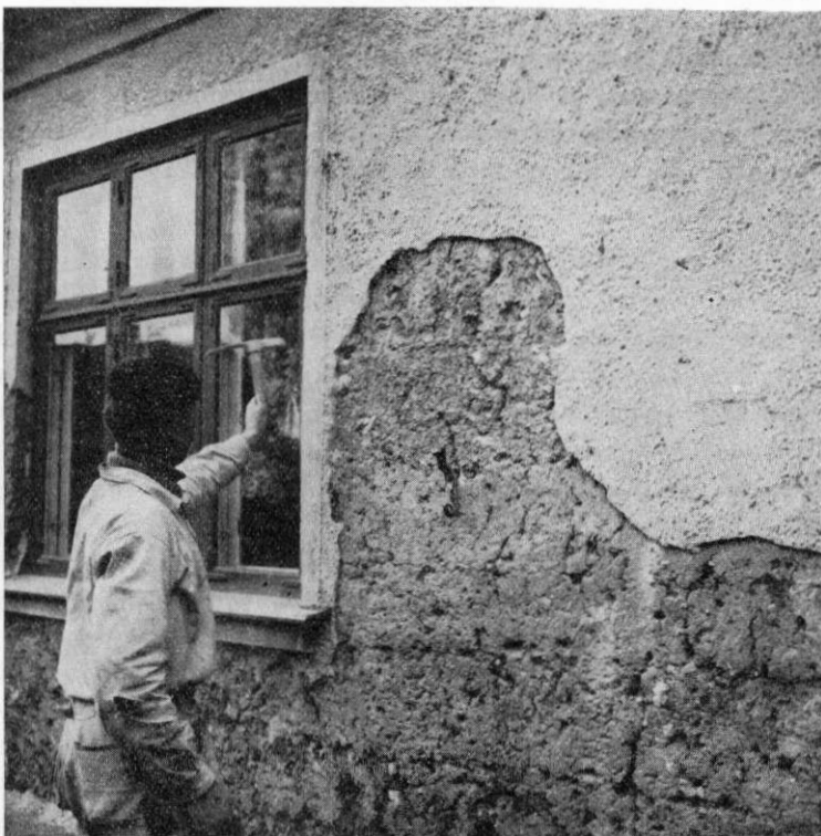
Kantorshuset under reparation, 1955. De sammanältade lerlagren framträder tydligt under väggarnas puts.
