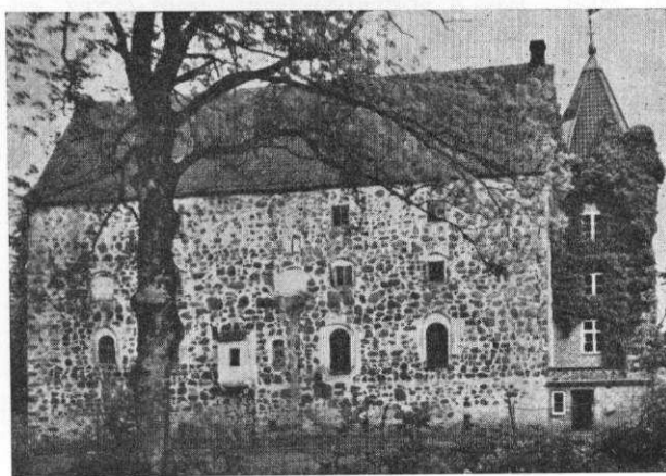
Örups stenhus från norr.
