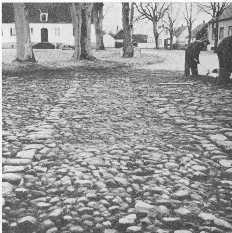
Skanörs torg under friläggning.
