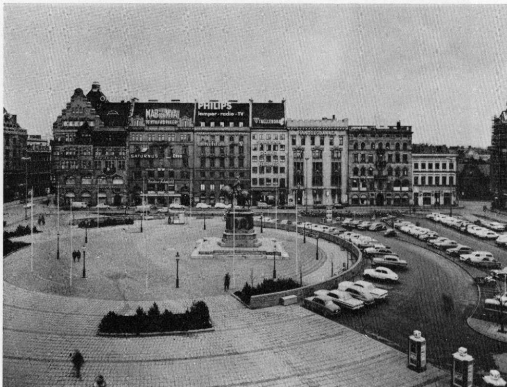
4. Stortorget, södra sidan. 1800-talsstadens representativa ansikte. Byggnadsår och arkitekt från höger: Före 1862, T. Wählin och A. Lönnberg 1900, T. Wählin 1902, C.-A. Stoltz 1947 (tidigare fasad 1880-tal), Aug. Stoltz 1918, Aug. Stoltz 1913, A. Anderberg 1904.
