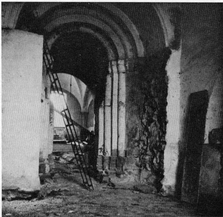
Sydportalen i Vä åter upptagen.
