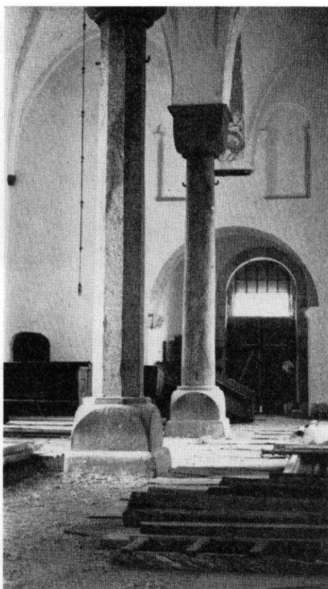
Långhuset mot väster. Ovanför bågöppningen till förhallen syns de nu igenmurade öppningarna till västemporen.
