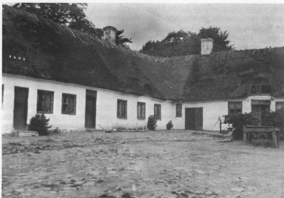
Fig. 2. Bara prästgård. Delar av norra och östra längorna. Norra längan, boningslängan, byggd omkr. 1729. Östra längan till vänster nybyggd på 1820-talet. Foto Nordiska museet.
