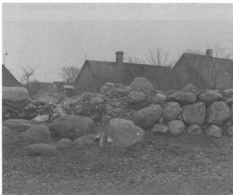
Parti av murens utsida efter framrensning. Foto: B. R.
