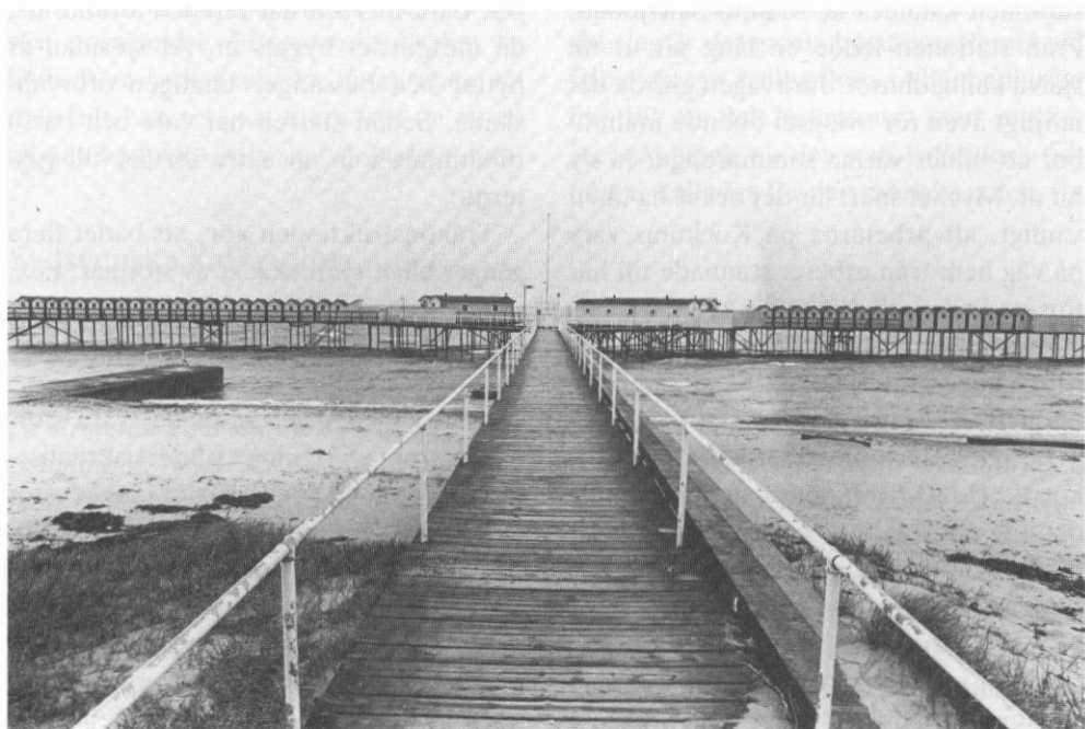
Pålsjöbaden, Helsingborg. Foto Helsingborgs museum, 1989.
