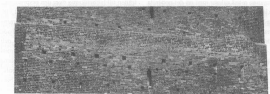
Fig. 7. Parti av Kärnans nordöstra fasad. Bilden visar åtta av de trettio bomhål som sitter på tjugo meters höjd. Hålen är betydligt större än hålen efter byggnadsställningarna och alltså avsedda för bjälkar av en kraftigare dimension. Inifrån ses två av hålen nederst på fig. 6. Foto: Helsingborgs museum, 1991.
