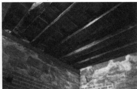
Fig. 2. Takbjälkar i Kärnans nedersta våning. Bjälkarna är infällda i muren och vilar på ett ramstykke av trä.
