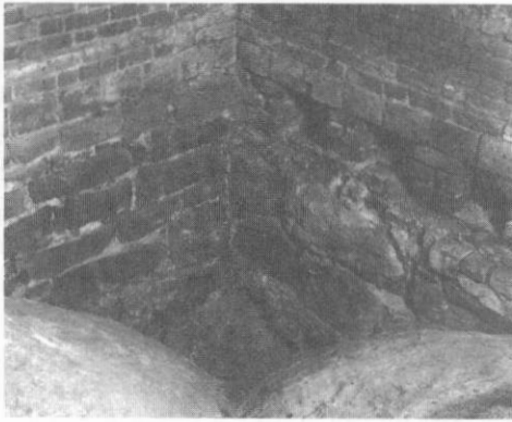
Fig. 6. Utrymmet över den tredje våningens valv, norra hörnet. Till höger ses tre bomhål efter takbjälkarna över den ursprungliga fjärde våningen. Valvet gjorde bjälkarna överflödiga som takbjälkar, och valvets höjd gjorde att de inte heller kunde användas som golvbjälkar. Även bomhålen i de övriga hörnen är bevarade. Foto: Torsten Mårtensson, 1932.
