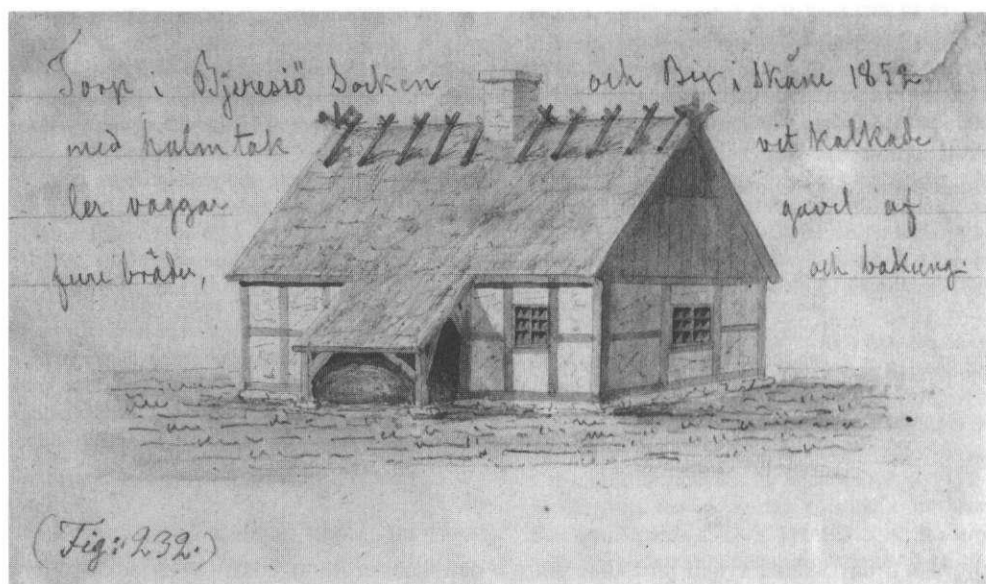
Nils Månsson Mandelgren, torp i Bjäresjö. Både bilden och texten runtomkring visar främst intresse för husets konstruktion.
