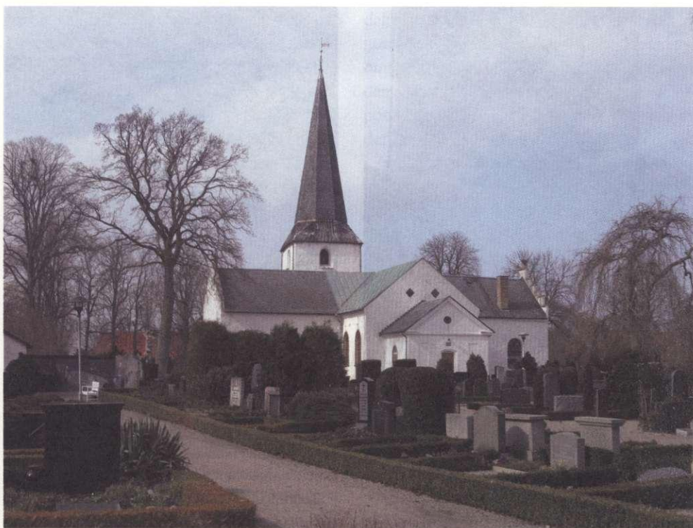
Kyrkan sedd från sydost.
