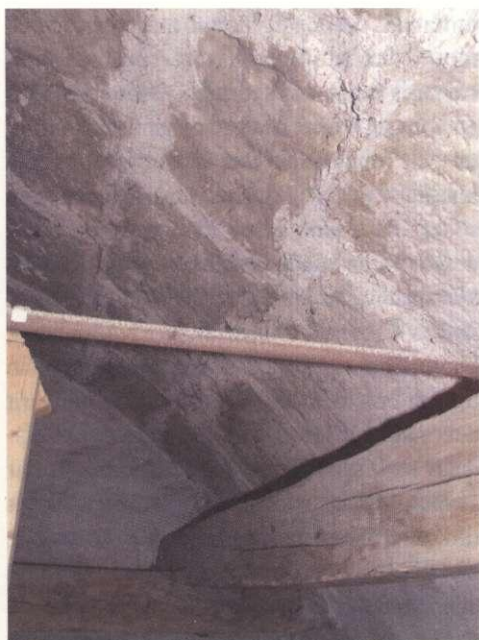
Sandstenskvadrar tillhörande tunnvalvet över tornets andra våning.
