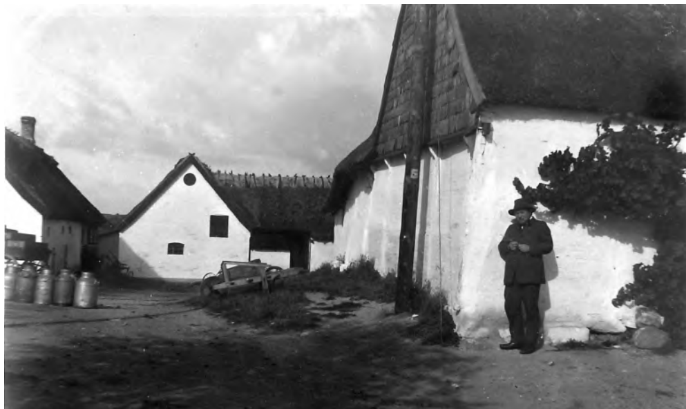
Gård på Reersø, en liten halvö som sticker ut i Stora Bält från Själlands västra kust. Här har Campbell i sina anteckningar noterat några karaktäristiska drag i bebyggelsen, som att korsvirkesstommarna är helt överputsade och att det är tätt med ryggrän på stråtaken. På Reersø besökte Åke Campbell 1920 författaren och folklivsskildraren Thorkild Gravlund, som poserar på bilden. Original hos institutet för språk och folkminnen, Uppsala.
