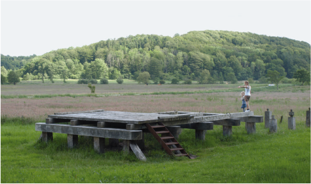
Fig. 8. Ravning bro på Jylland från 980 är den enda referens vi har från tiden för Kävlinge bros omnämmande. Bilden visar ett rekonstruerat parti av bron på platsen för fyndet (Foto: AÖ).
