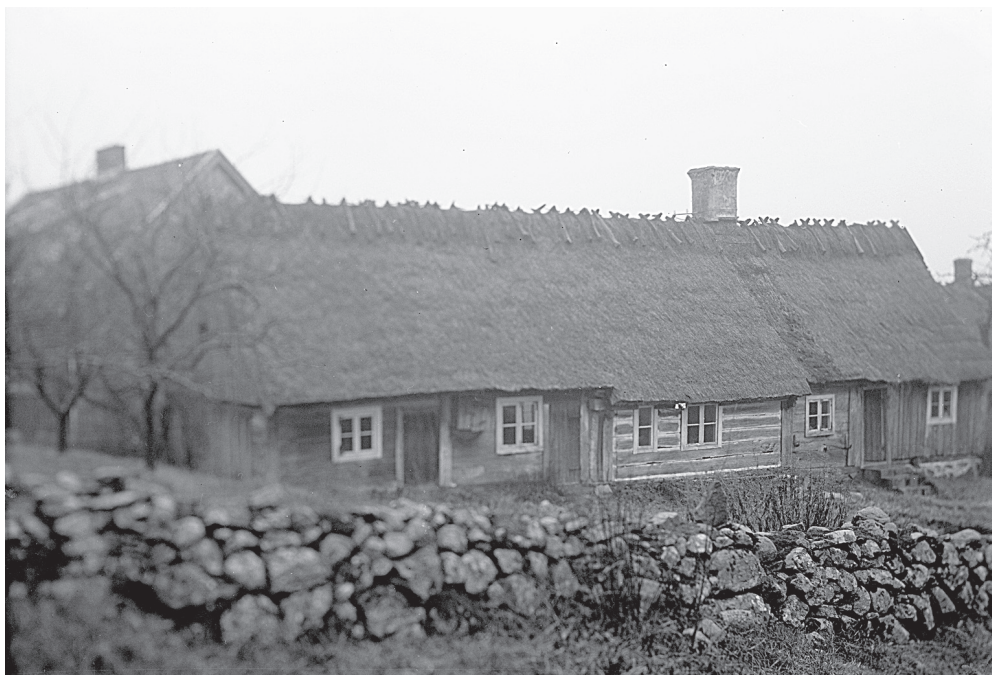
Hagstadstugan, en sydgötisk manbyggnad i skiftesverk, fotograferad av Harald Olsson på ursprunglig plats i Norra Rörums socken. För att bevaras måste den flyttas 1942. Det gav Harald Olsson både arbetsuppgifter och tillfälle att studera byggnadsdetaljer. Ny plats blev Frostavallen. Regionmuseet Kristianstads arkiv, Skånes hembygdsförbunds samlingar.
