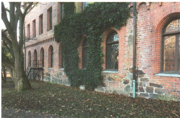
Fig. 3. Mur från det medeltida Lundagård synlig i Kungshusets norra yttervägg. Foto: Jes Wienberg, november 2020.
